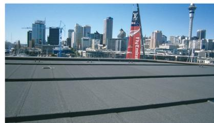
**SISTEMI PER L'IMPERMEABILIZZAZIONE CHE PREVEDONO L'UTILIZZO DI PARTICOLARI MEMBRANE BITUME POLIMERO CON RILASCIO DI GARANZIA DECENNALE ESTESA ALLA FORNITURA E POSA IN OPERA CON PROGRAMMA DI MANUTENZIONE.**
